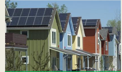
300 kW Colorado, USA
